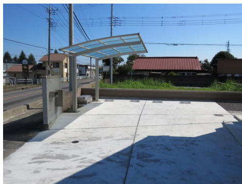
新設カーポートで、大切な車をしっかり守ります◎
