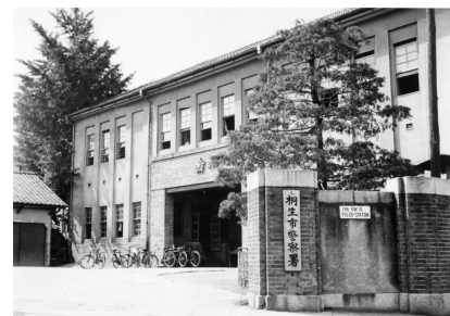
←昭和9年(1934)建築 外壁はスクラッチタイル張り。屋根は青緑色の日本瓦葺。2階の窓にはステンドグラスも使われています。
